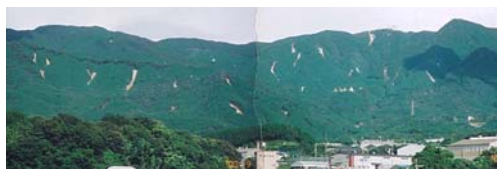
三郡山西側の斜面崩壊発生箇所
