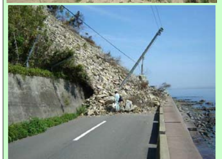
地震ワーキンググループ現地調査状況
