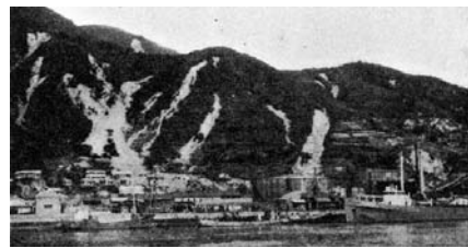
"悪魔の爪痕"と呼ばれた 門司・風師山系の斜面崩壊
