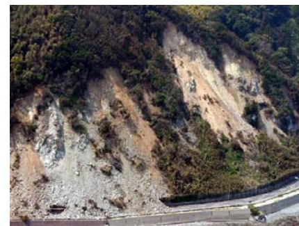
志賀島東側斜面で発生した斜面崩壊の全貌
