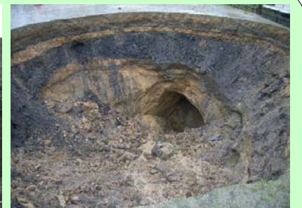
現在も発生する浅所陥没
