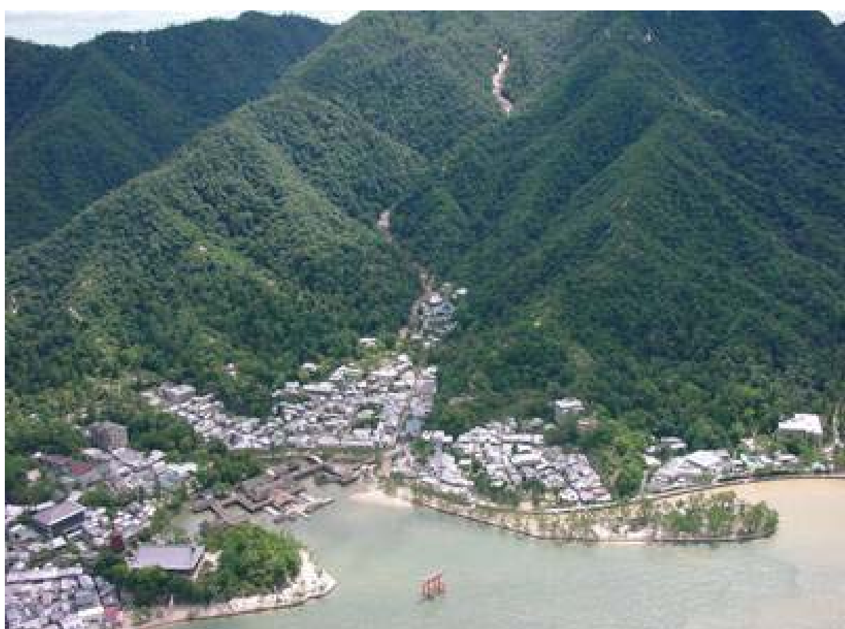
厳島神社と平成17年の土石流（広島県砂防課提供）
