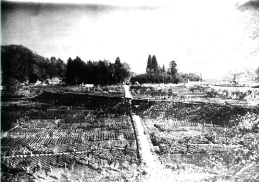
濃尾地震 (1891年10月28日) で地表に現れた根尾谷断層
