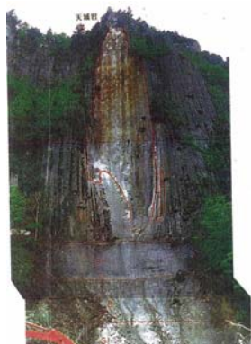
② 昭和62年 天城岩の岩盤崩壊 (写真:北海道開発局)
