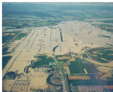
① 昭和56年 台風12号による豪雨災害 (写真:北海道開発局)
