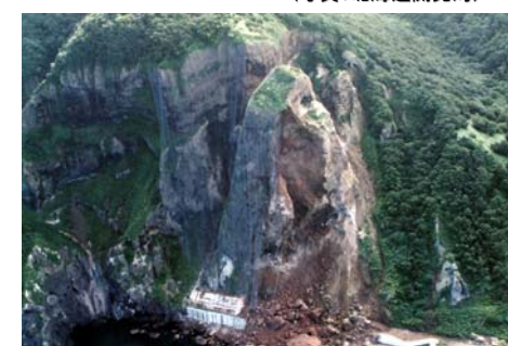
⑥ 平成10年 第二白糸トンネル岩盤崩壊
