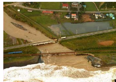
⑨ 平成15年 台風10号豪雨災害 (写真:北海道開発局)
