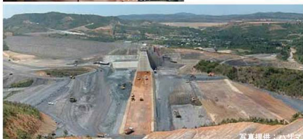
▲ 海外における大型土木事業の例 (ベトナム：建設中のダイニンダム)
