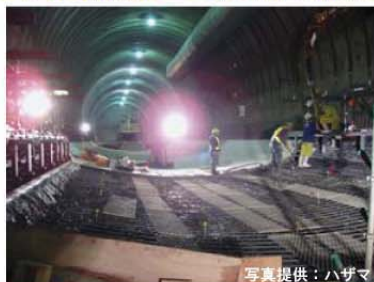
◀ 国内における土木事業の例 (鹿児島：新武岡トンネル)
