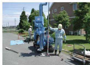
▲ 土壌・地下水汚染調査での調査用ポーリング実施状況
