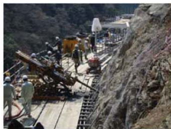
▲斜面対策工事の例
