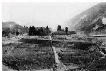
▲濃尾地震直後の根尾谷断層(水鳥断層)の変位状況 (Koto,1893)
