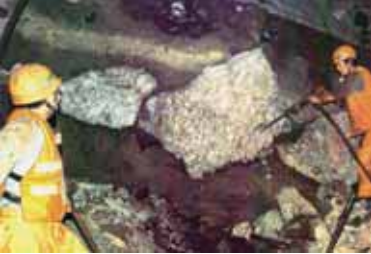
▲青函トンネルの泥岩とそれに含まれる流紋岩質凝灰岩の巨礫 (写真提供：鉄道・運輸機構)
