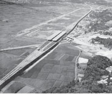
▲建設中の新横浜駅の高架橋
