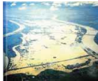
◀長良川の破堤状況(昭和51年9月)
