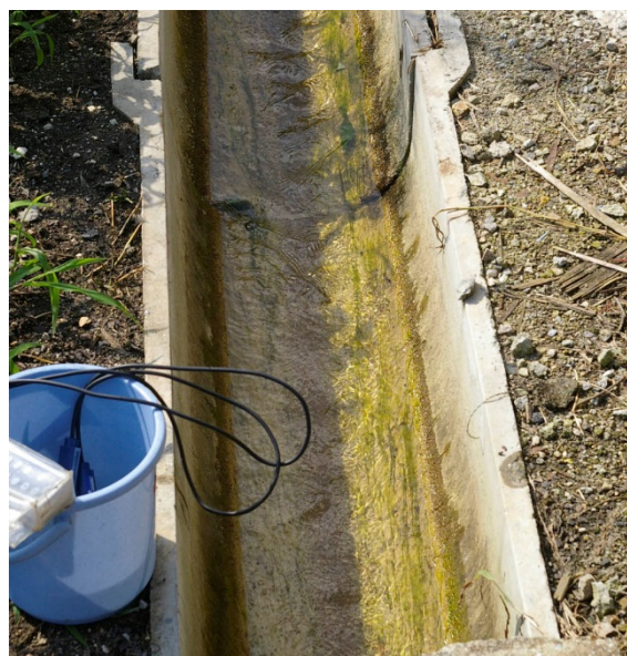
写真-4 浸出水によるセメント分の浸食（左）、用水路に発生した藻（右）
