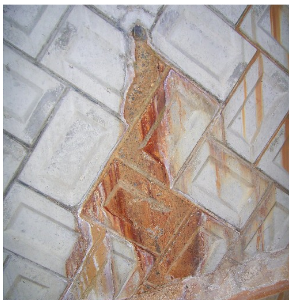
写真-4 浸出水によるセメント分の浸食（左）、用水路に発生した藻（右）
