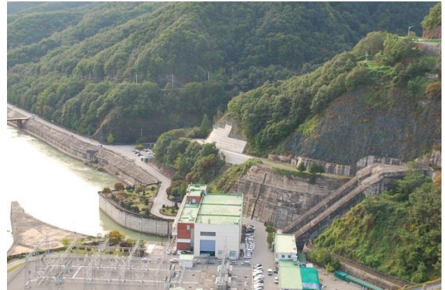
写真-5 分厚いコンクリート装甲の水圧管路
