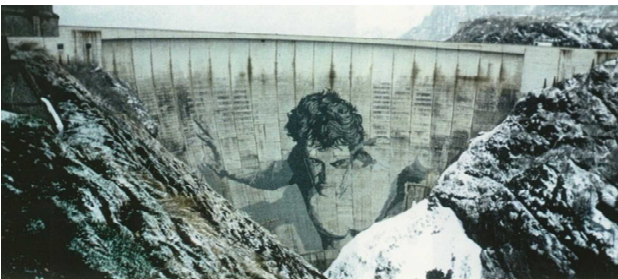
写真-1 巨大なヘラクレスが支えるティニユダム
