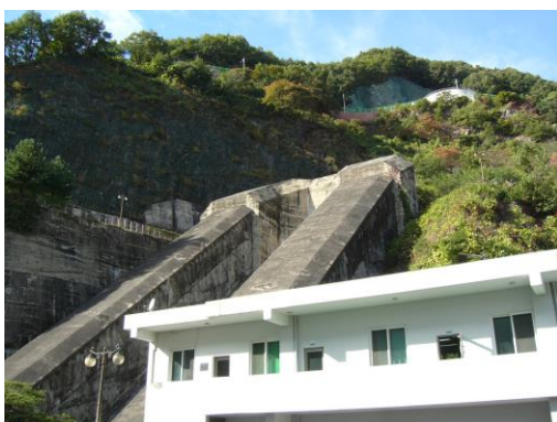
Soyang River Dam コンクリートで補強された水圧鉄管路
