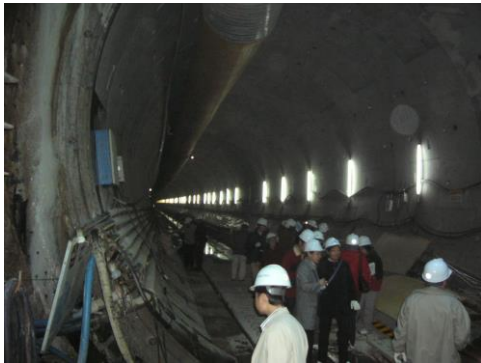
ソウル市内 地下鉄シールドトンネル建設現場の視察
