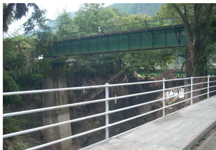
夜明駅北北西数百 m の鉄道橋の流木の状況（図 2-1 の図面外）
