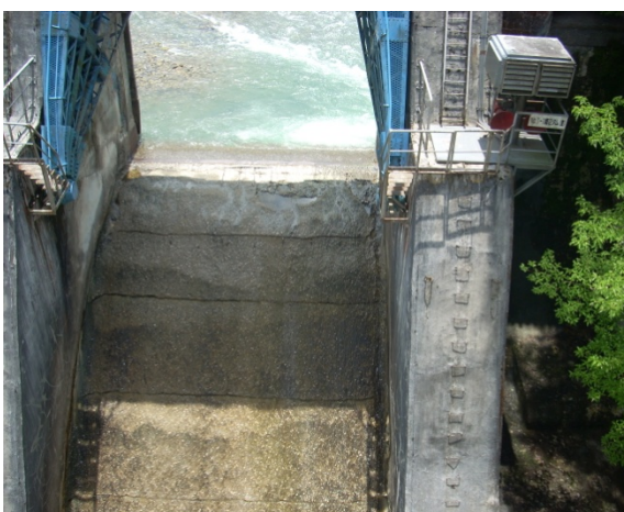
写真-4.2.2.3.3 ダムのゲート底部の状況
