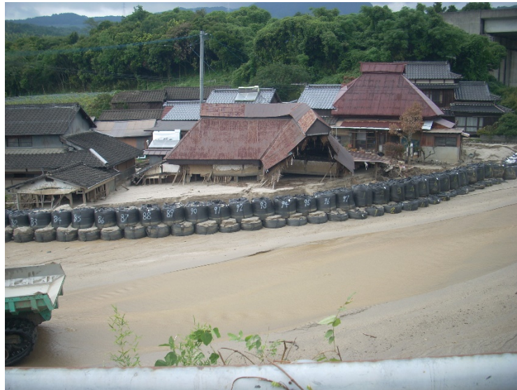
P.4：土砂に埋まった家屋の状況
