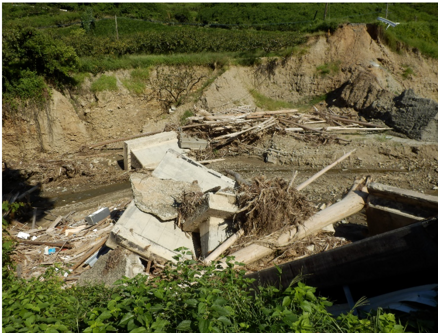
写真 2-3-2 崩壊した堤体の状況（平成 29 年 9 月 22 日撮影）
