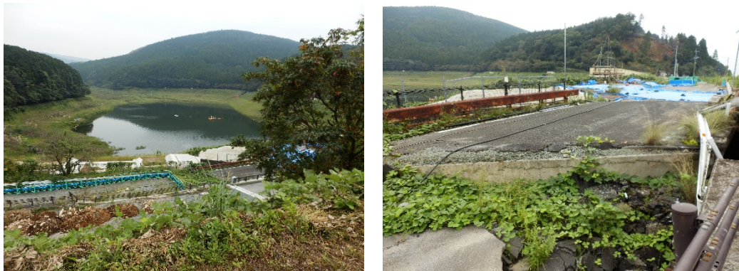
写真 4-1-2-3 大切畑ダム全体の状況（平成 29 年 9 月 23 日撮影）
