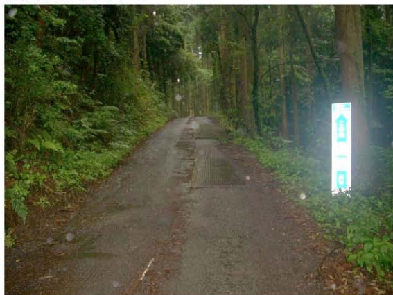
b) 西側100m 離れた道路の段差
