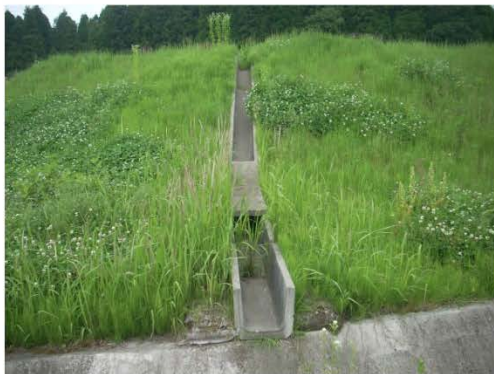
c) 法面流下側溝に変状なし
