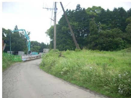
e) 中央の電柱付近の法肩の亀裂
