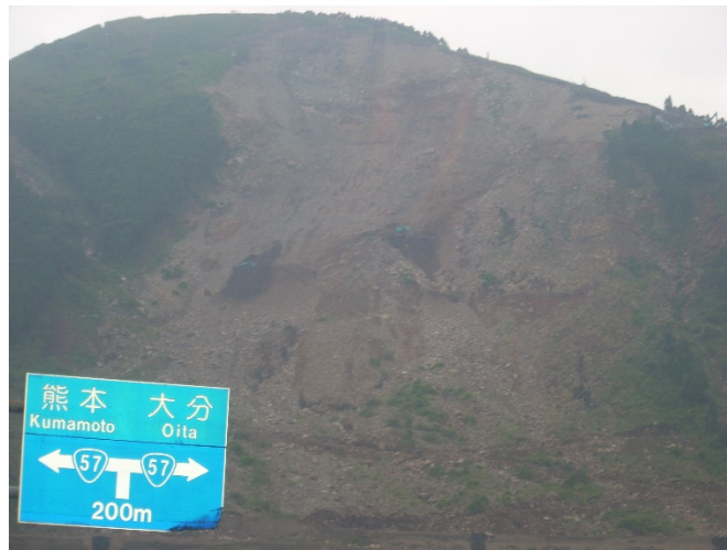
PH.1 : 阿蘇大橋の右岸の斜面崩壊状況 : 現在も対策中
