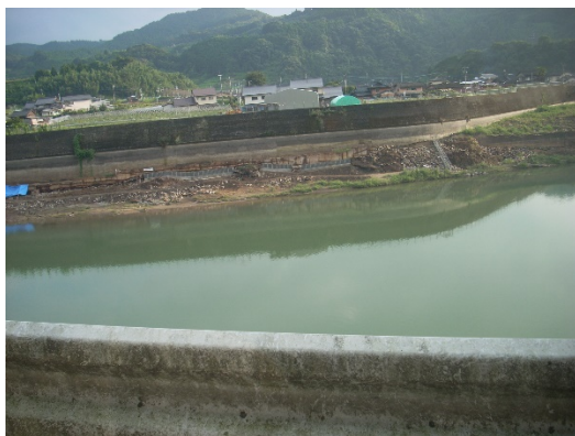
夜明ダムの状況（図 2-1 の図面外）：ダム湖岸の洗堀（左）、ダム本体は正常（右）
