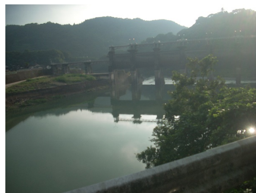
夜明ダムの状況（図 2-1 の図面外）：ダム湖岸の洗堀（左）、ダム本体は正常（右）
