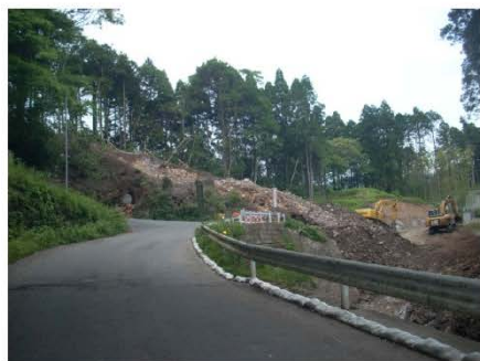
f) 法肩の斜面崩壊
