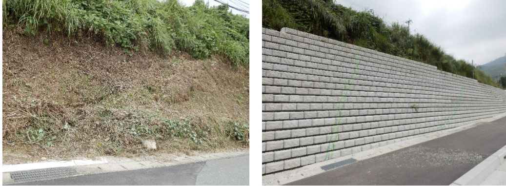
写真 4-1-2-2 大切畑付近のクラックとダム全体の状況（平成 29 年 9 月 23 日撮影）
