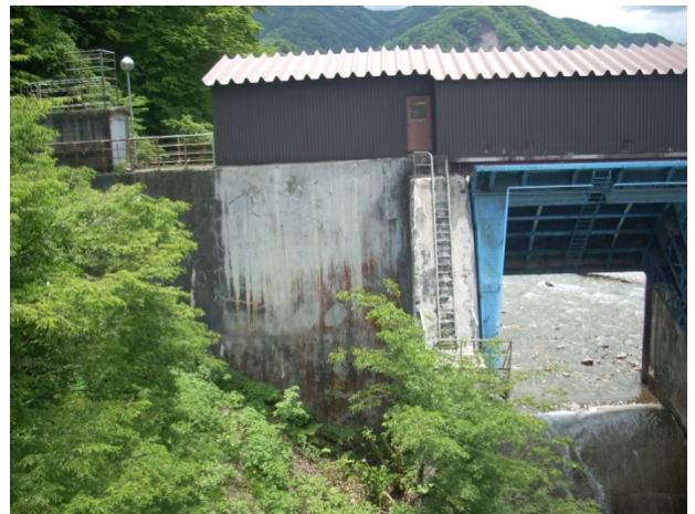
写真-4.2.2.3.5 ダムの右岸部
