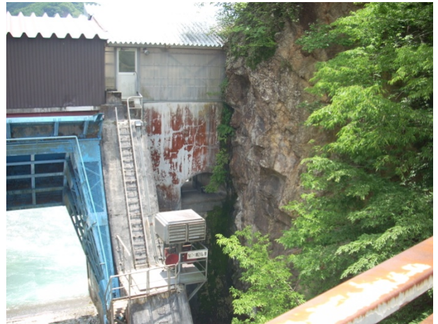
写真-4.2.2.3.4 ダムの左岸部
