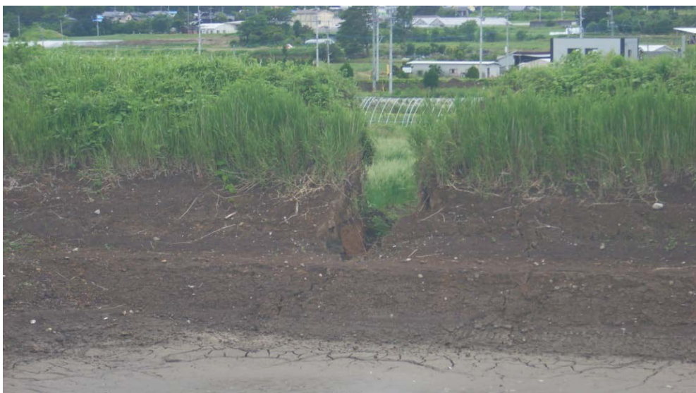
写真 4-1-1-1 下小森ため池の決壊箇所状況 (平成 28(2016)年 6 月撮影)
