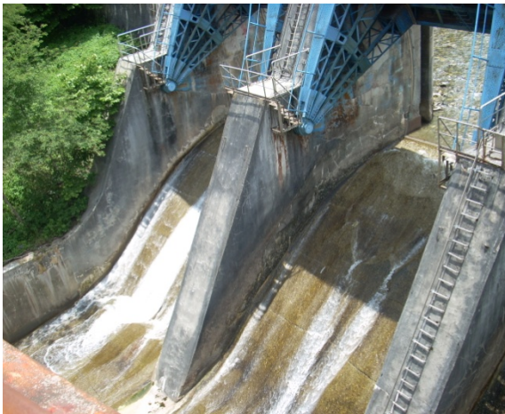
写真-4.2.2.3.2 ダムのゲート部
