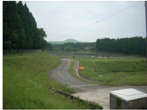
d) 道路法面（写真左）に変状なし
