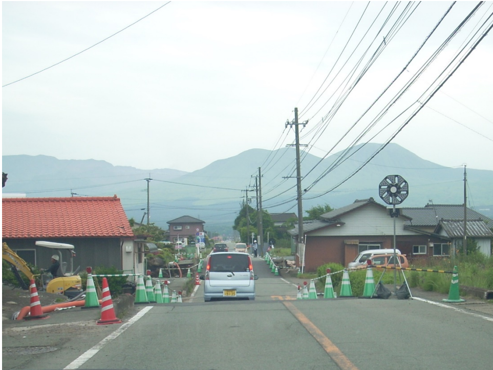
写真 1-2-1 2016 年熊本地震による阿蘇市の陥没状況（平成 28 年 6 月撮影）
