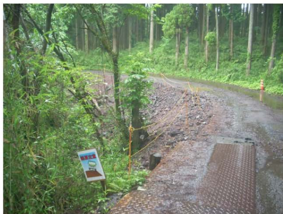
c) 西側200m 離れた道路の路肩部の小崩壊
