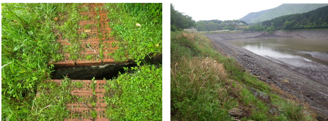
写真 4-1-2-1 大切畑ダムのクラックとダム全体の状況 (平成 28 年 4 月 23 日撮影)
