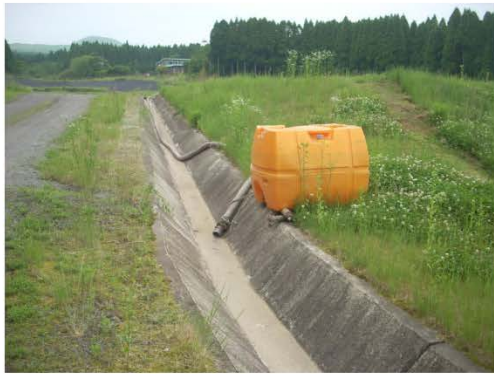
a) 側溝の変状なし
