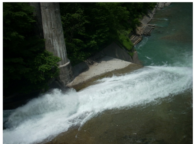
写真-4.2.2.3.6 ダムの放流状況
