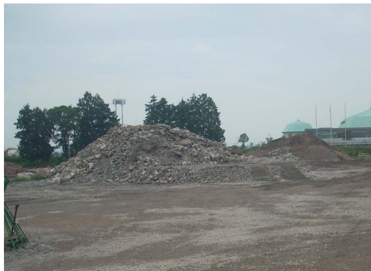
仮置き場の地盤は全面露出状態
