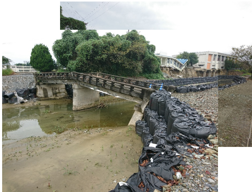
P.1 : 河岸・河床洗堀等により、橋や建築物が傾動した状況
