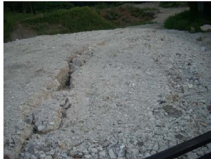
d) 覆土に用いられると思われる盛土に亀裂が見られるが、崩壊に至るようなものではない。
