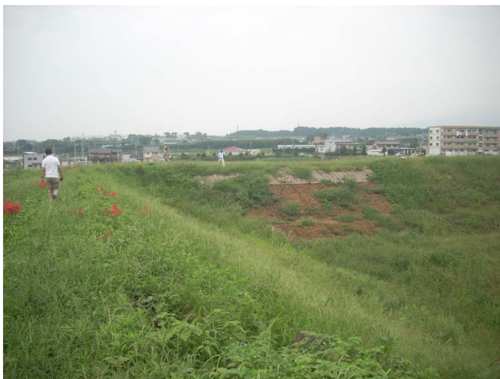
写真 4-1-1-2 下小森ため池の決壊箇所の修復状況 (平成 29(2017)年 9 月撮影)
