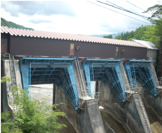
写真-4.2.2.3.1 姫川第二ダム(平成27年6月20日撮影)
