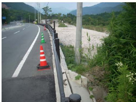
c) 道路のずれと亀裂
