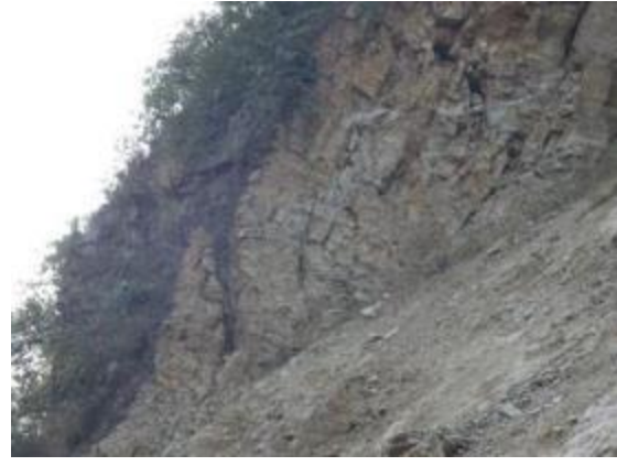
トップリング変形、座屈変形が進み、岩盤内の空洞が見える。
