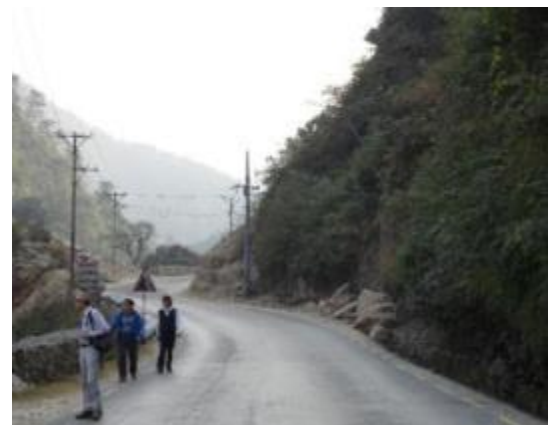
落石危険の交通標識と緊張した面持ちで通過する参加者。
