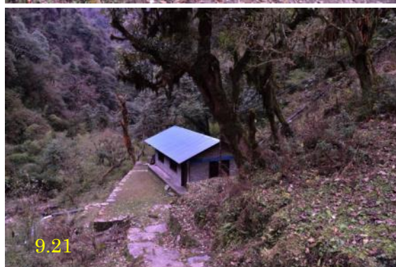
写真-9.18~22 Tadapani Hydro Electric Plant 取水堰堤のない落差 400m の比較的新しいミニ水力. 全て自国製.
