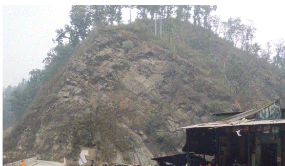
写真-6.18 橋梁脇の法面や斜面で剥離崩壊 写真-6.19 流れ盤をなす剪断面に沿って崩壊
