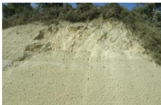
強風化した基盤岩とのり面保護工
