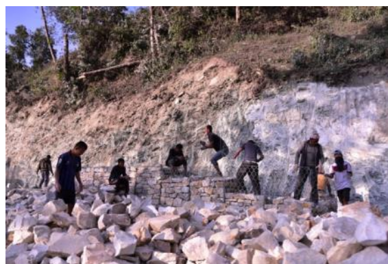
写真-9.6 道路工事でよく使われている蛇籠
