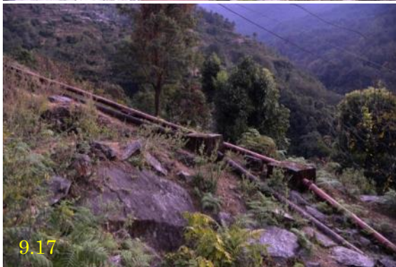
写真-9.15~9.17 Tirkhedhunga Hydro Electric Plant 送電系統から離れた地域電化に適したミニ水力
