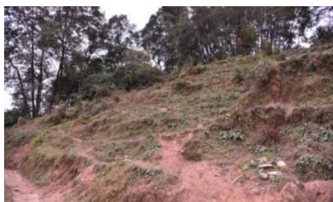
写真-9.28 ガンドルン地すべり頂部付近の状況
