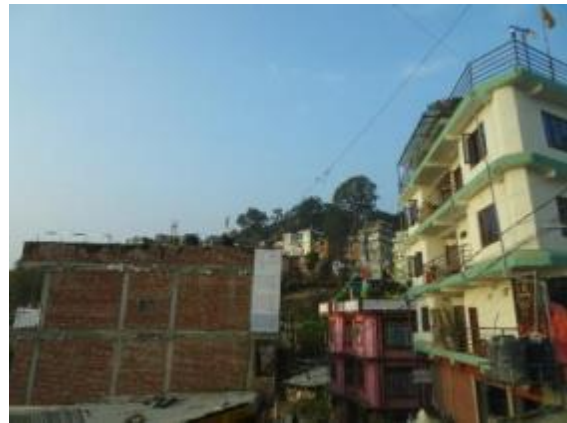
斜面上に中層住宅があるが、被災したようには見えない。
