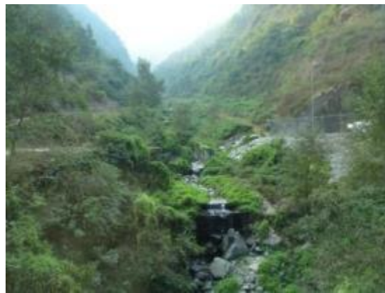
砂防ダム工による復旧対策。溪床にも植生が復旧して、災害の面影はない。
