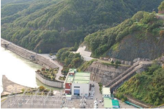
写真-2.5 分厚いコンクリート装甲の水圧管路
