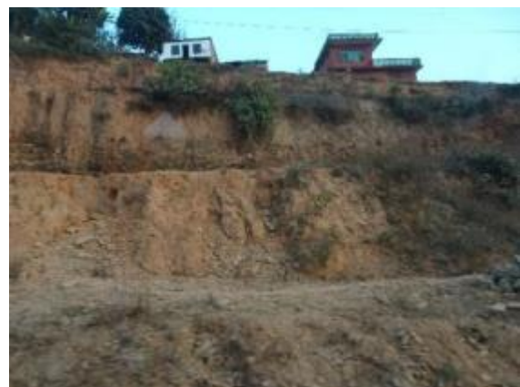
ゴルカの町はずれに見られた切土のり面。強風化して土砂状の地盤。
