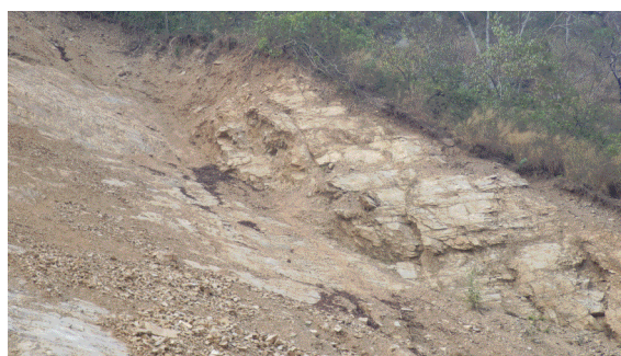
写真-6.18 橋梁脇の法面や斜面で剥離崩壊 写真-6.19 流れ盤をなす剪断面に沿って崩壊
