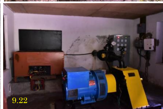
写真-9.18~22 Tadapani Hydro Electric Plant 取水堰堤のない落差 400m の比較的新しいミニ水力. 全て自国製.
