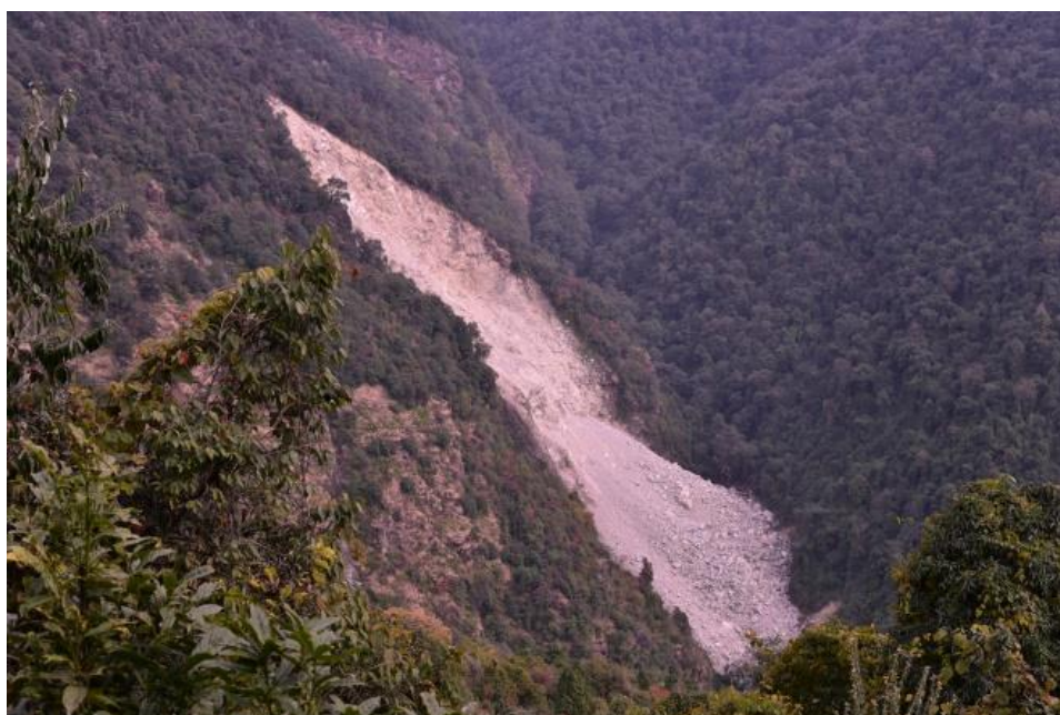
写真-9.25 バンタンティ直下の深層崩壊 ダウランティ・コーラ川を閉塞している。
