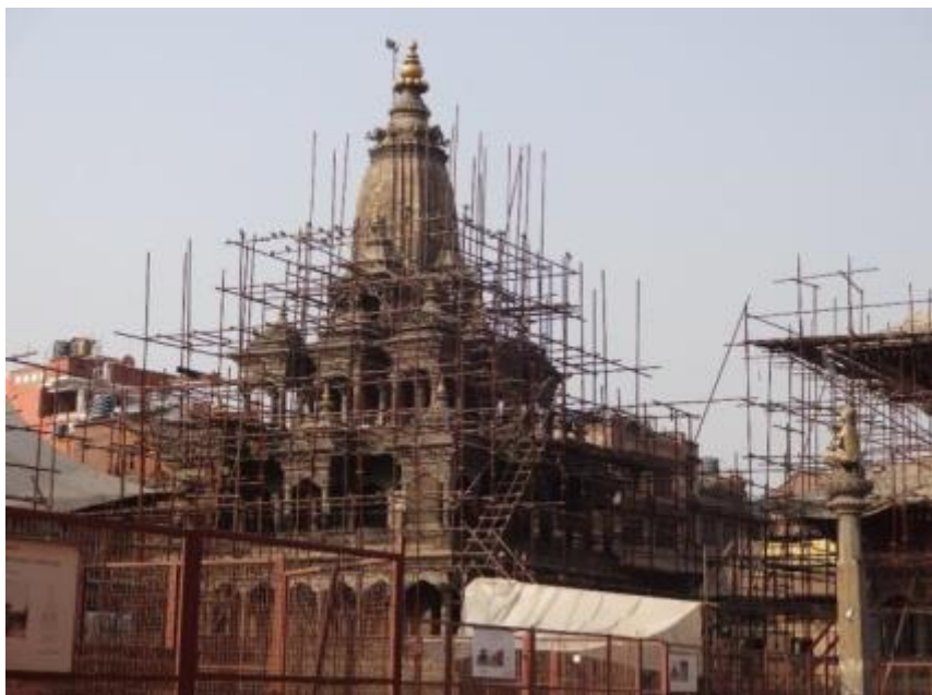
写真-4.4 修復中の寺院
