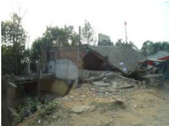
被災した建物。柱と梁は鉄筋コンクリートのようであるが、かなり細いようだ。
