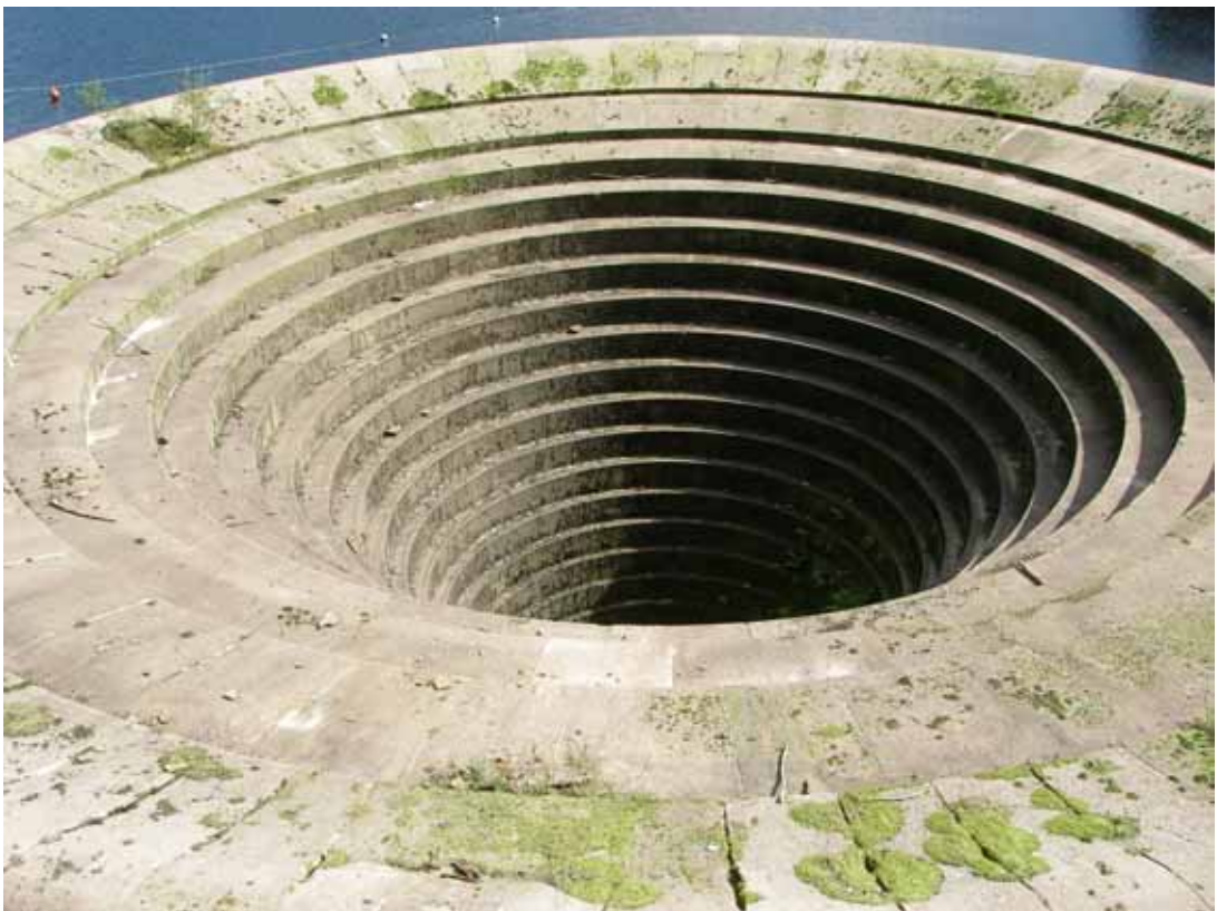
P-6 : Ladybower ダム シャフト洪水吐き。同上の近景。
