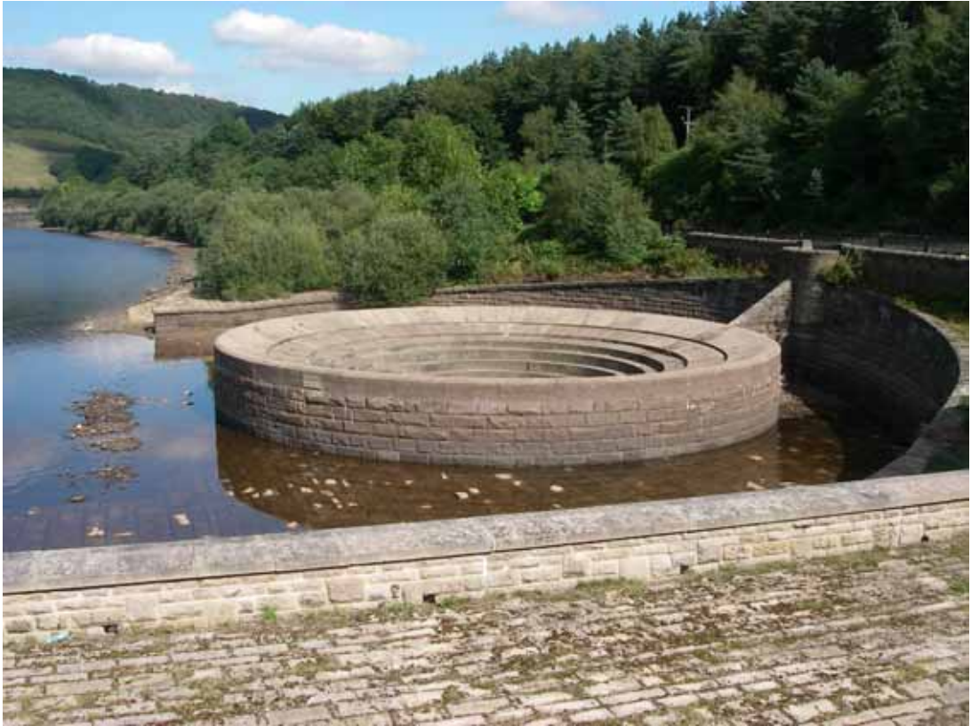
P-5 : Ladybower ダム シャフト洪水吐き。左右岸に1基ずつある。
