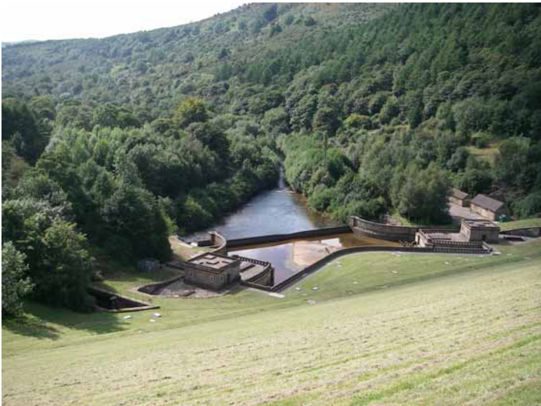
P-3 : Ladybower ダム下流面と下流の河道。左右対称のシャフト洪水吐きの吐口が見える
