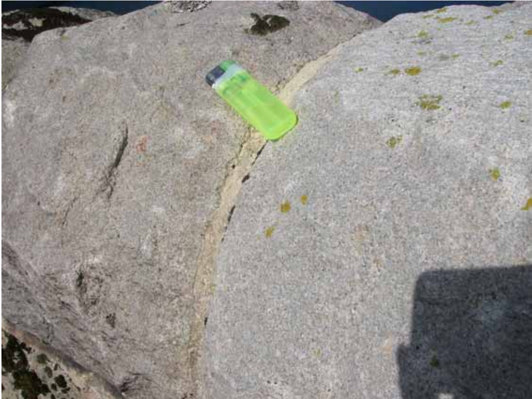
P-9：石張は、硬質の砂岩を使用。おそらく貯水池に広く分布する Upper Carboniferous の砂岩 (grit stone)
