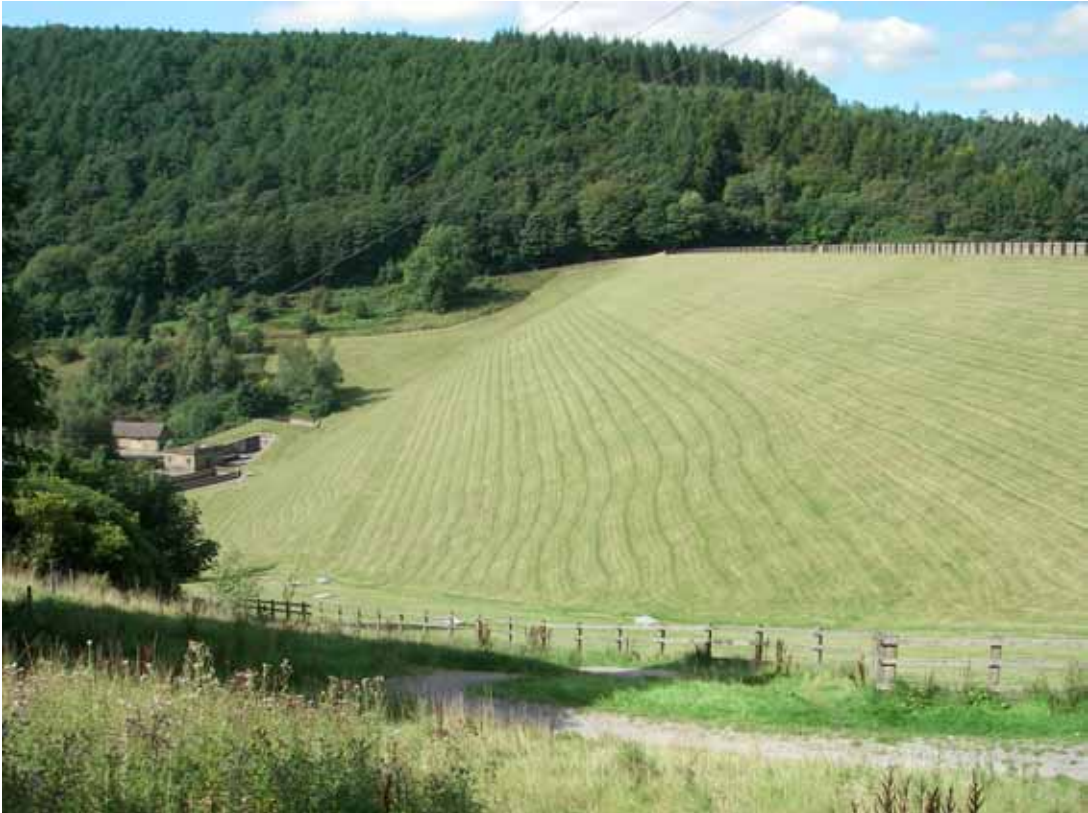
P-1 : Ladybower ダム下流面（アースダム？） H=50m?、最下流のダム（すべて水道用）
