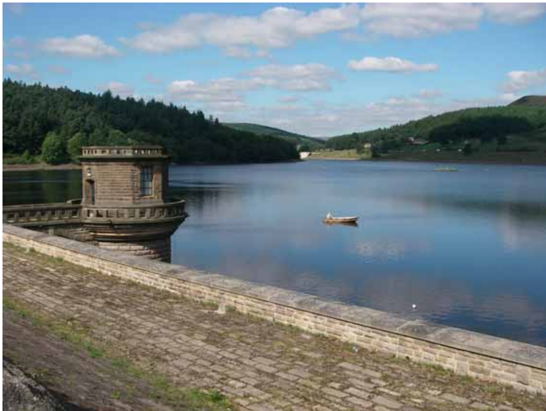
P-8 : Ladybower ダム 貯水池。見えているのは取水塔?。湛水面より上部は石張。
