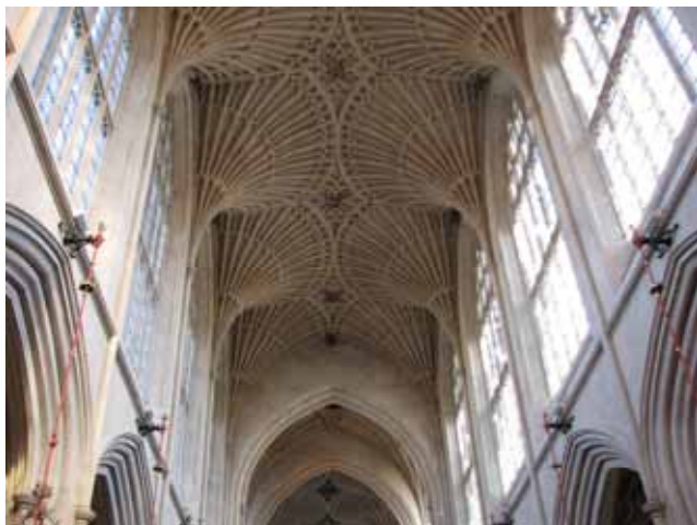
写真-6.3.3 バース寺院の天井 16世紀のファン・ヴォールトと呼ばれる天井のデザイン。
