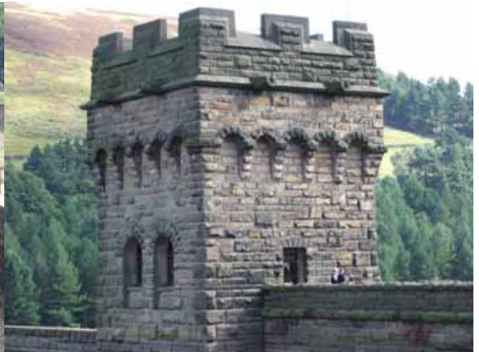
写真 - 8 堤体上の古城風な管理塔（左右に 2 基）通常の管理の他、博物館として使用している
