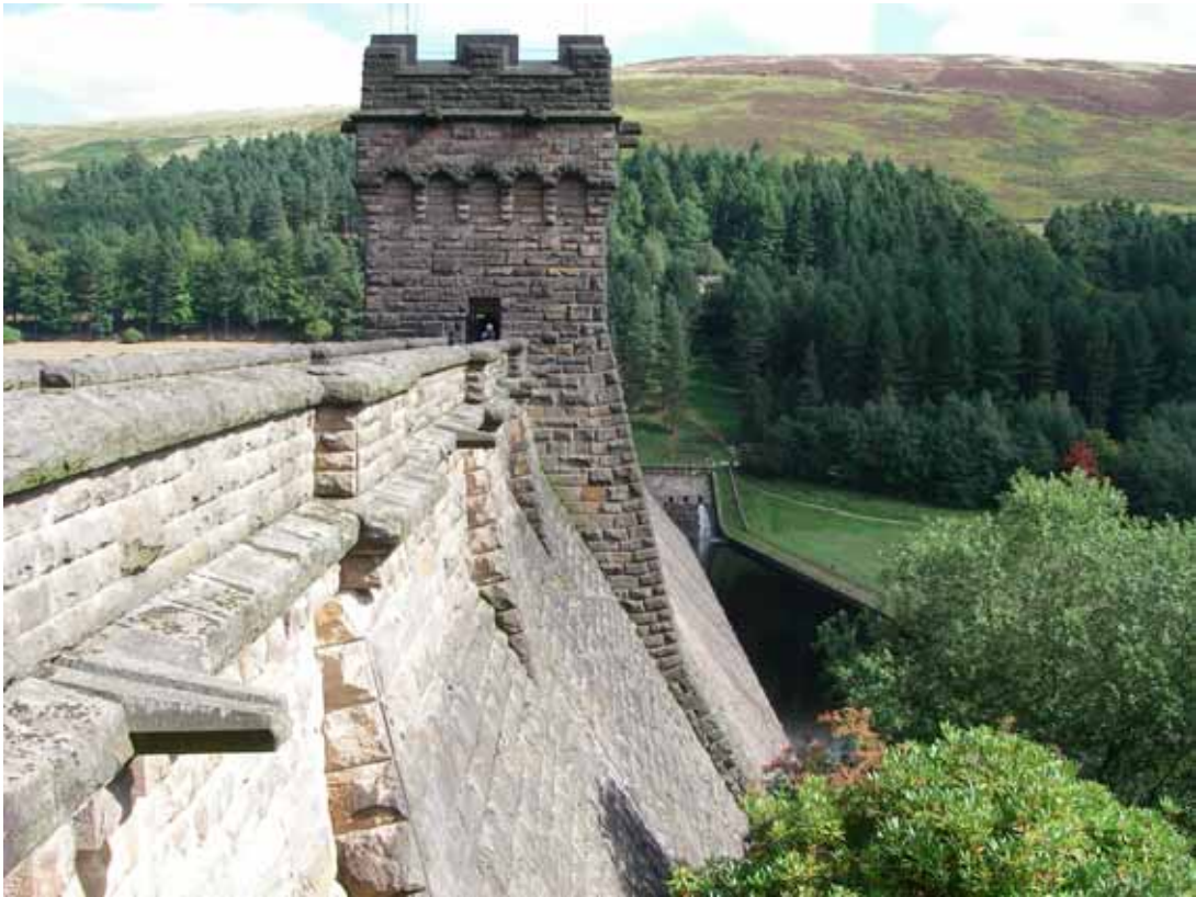
P-15 : Derwent ダム。表面は砂岩による石張り。
