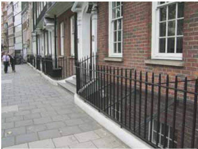
テラス・ハウスの例 主階の前にドライエリアと鉄柵がある典型的な形式。(バッキンガム宮殿近くにて)
