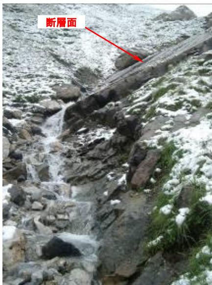
写真 4.13 石灰岩と角礫岩との境界（断層面） 地形的に沢を形成している
