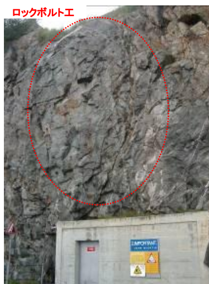
写真 4.8 ロックボルト工 直接岩盤に施工されている
