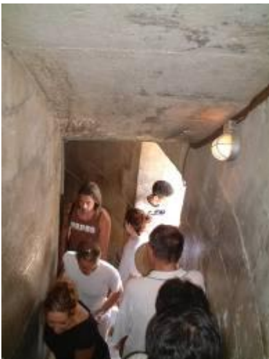
螺旋階段の状況
