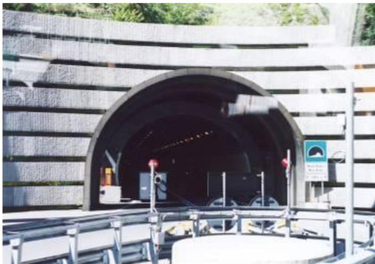
P-5 モンブラントンネルイタリア側坑口
