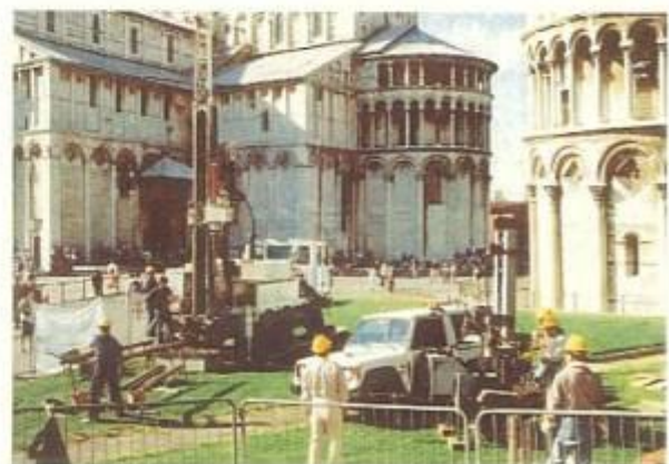
口絵写真—24 ボーリングマシン (左側)
