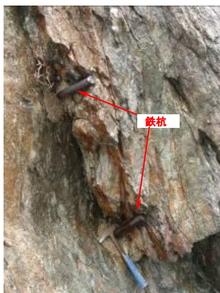
写真 4.7 落石防止工 楔岩塊の落石を鉄杭で防止
