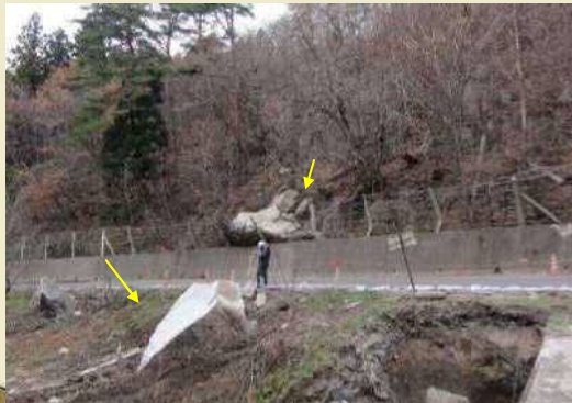
斜面上の露岩からの岩塊の落下。 谷側にある岩塊も落下岩塊
