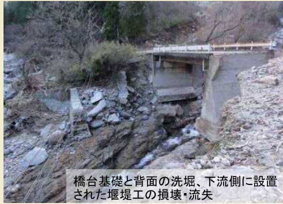
橋台基礎と背面の洗堀、盛土の崩壊
