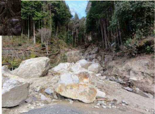
溪流出口部に堆積した巨礫。径1～3m。
