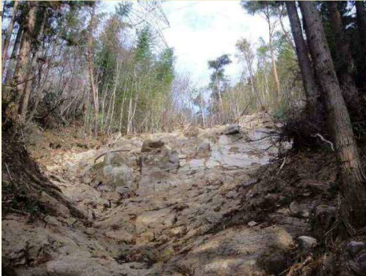
崩壊面中部に露出する弱風化の花崗閃緑岩。 東西方向の節理面が流れ盤をなす。
