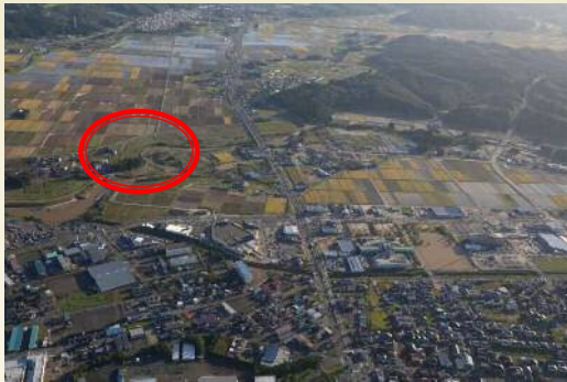
越流地点斜め写真(国土地理院10/13)
