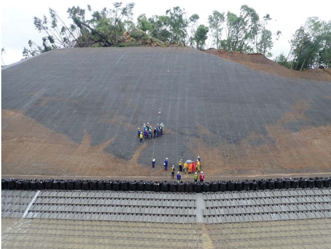
写真-2 水路掘削で出現した移動土塊（上位の暗灰色部）と河床堆積物（下位の茶色部）の接触面。移動土塊の割れ目に河床堆積物が注入されている様子が観察できる。
