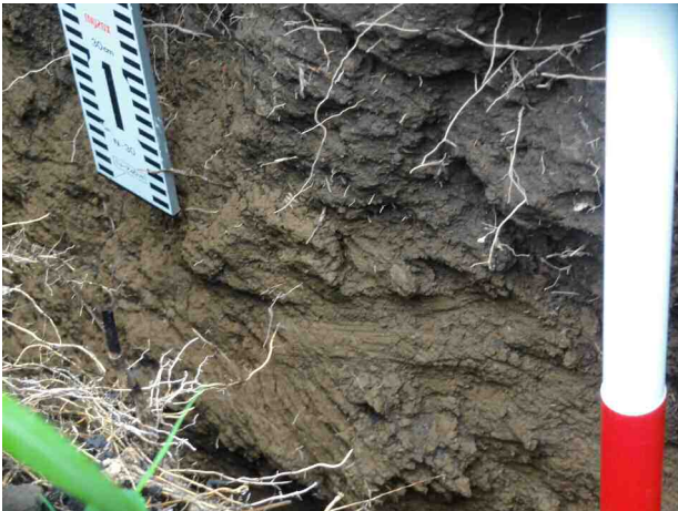
図－2 1 条線のある地表亀裂（図－2 0 c 付近）
