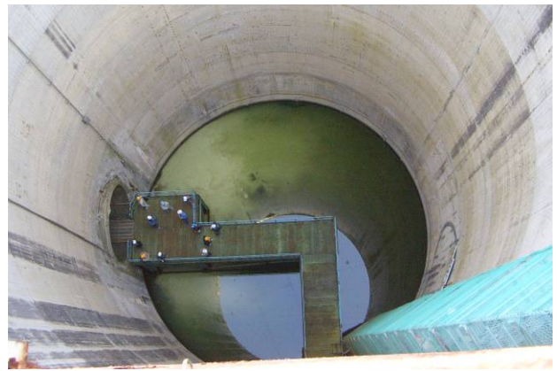
写真-6 立坑と導水路の状況
